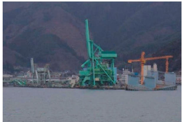
写真 23 倒壊したクレーン及び乗揚げた台船。
