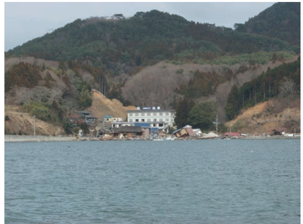
写真11 倒壊した木造住宅と後方の津波の被害を受けた旅館。
