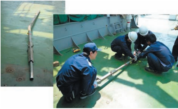
写真4 ポール屈曲・修理.
