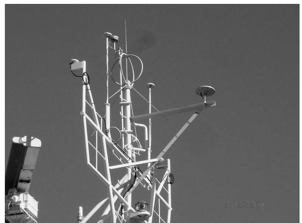
写真3 KGPSアンテナ取付け状況
