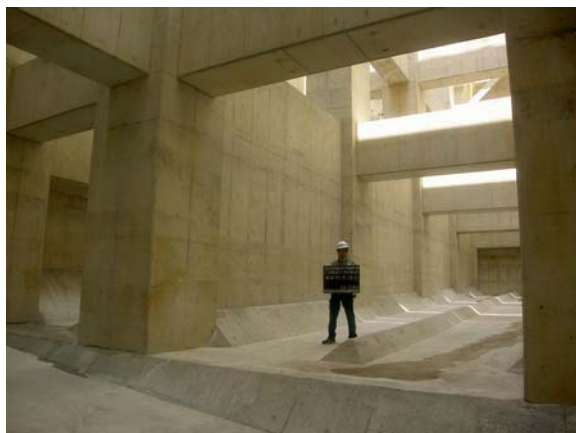
中央雨水ポンプ場雨水滞水池（H23年4月供用開始）
