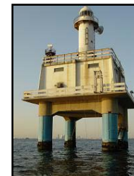
千葉灯標モニタリングポスト
