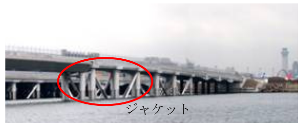
写真-3 北側場周導路（現空港側）
